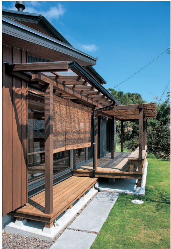
和室とLDKが外でつながるウッドデッキ。手摺を兼ねたベンチは眺めを楽しむにも便利。透明の庇は冬場の採光に活躍。夏はヨシズ・スタレを使って窓に陽を当てない
