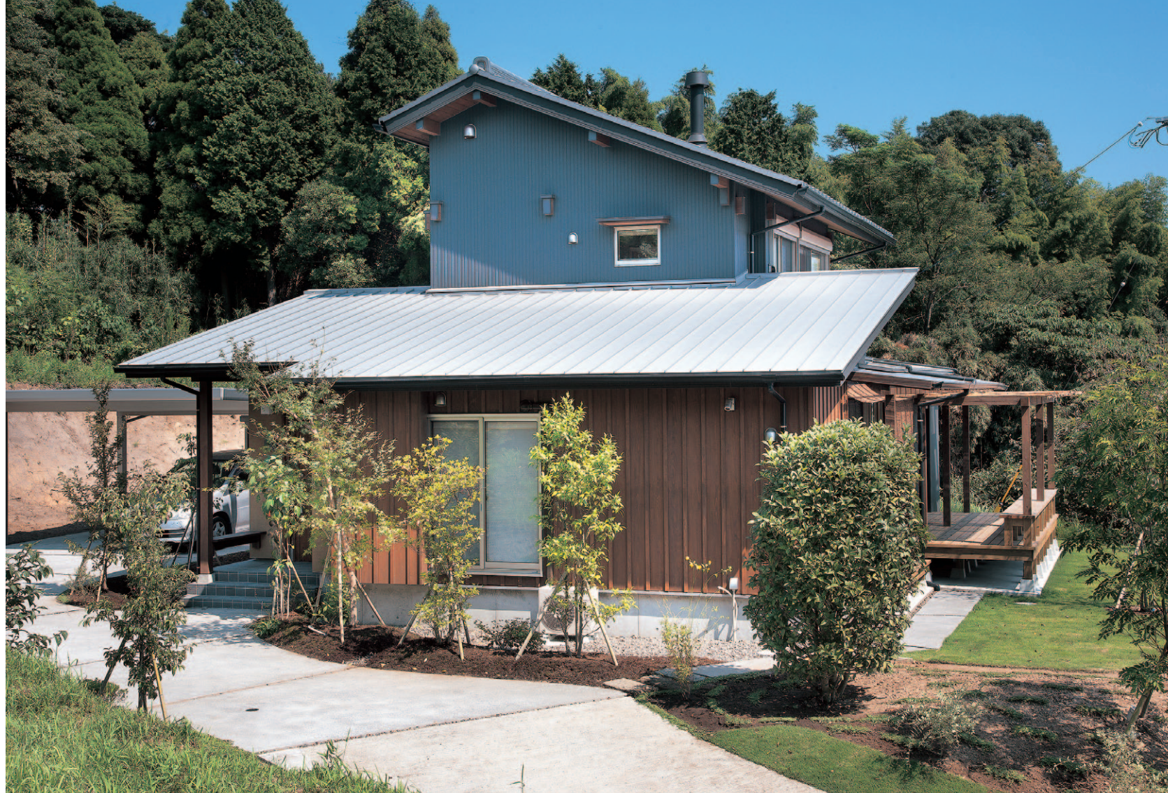
緑が残る高台の立地を生かし、コンパクトかつ機能的なデザインに。軒や庇の長さは、年間を通したシミュレーションで、冬の太陽熱の取り入れと、夏の日射遮蔽を綿密に検討。夏は、スタレやガラリ付雨戸を利用してどの方向の窓にも日射を当てない工夫が
