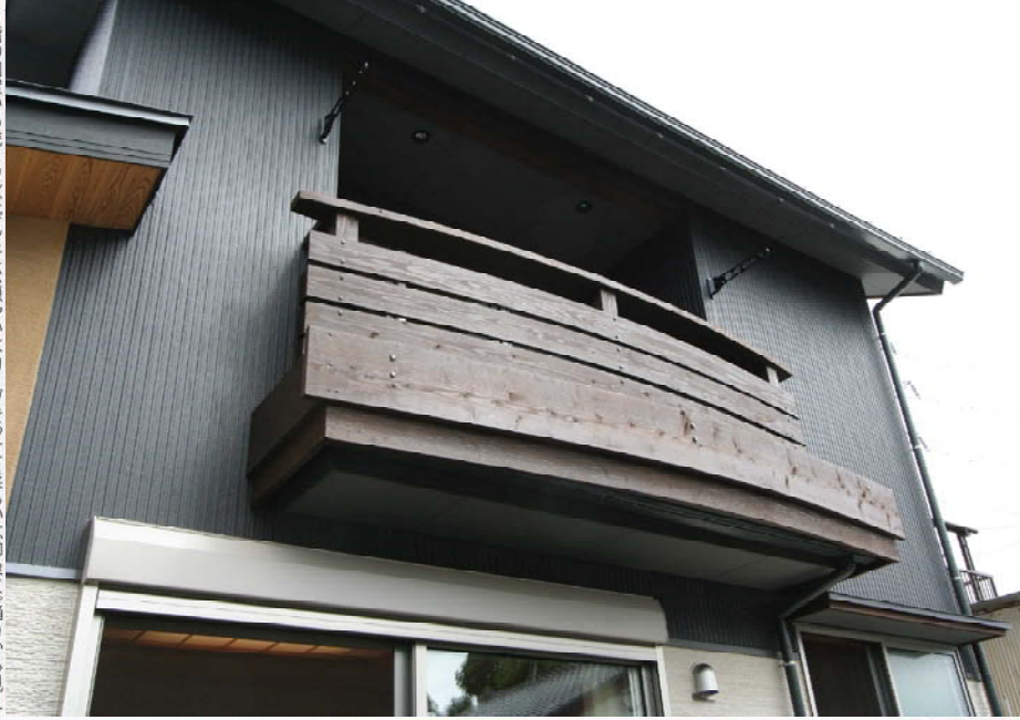
2階の個室から続くウッドデッキは、穏やかなカーブをつけて柔らかな印象に、通りから見るととも意識されたデザイン。
